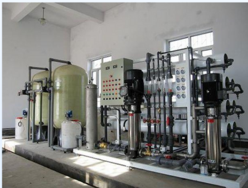
Conjunto de Osmose Reversa Duplo Passo
